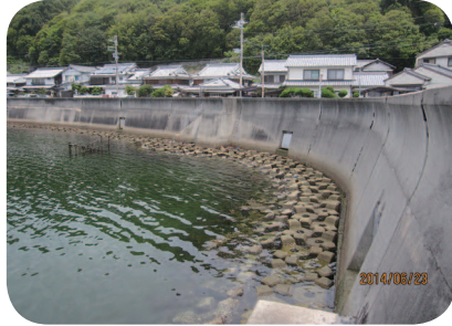
坂越の防潮堤
